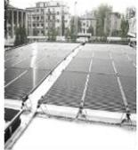
Installazione di un **impianto fotovoltaico** con potenza di picco 9 kW, in grado di produrre circa 8550 kWh/anno
